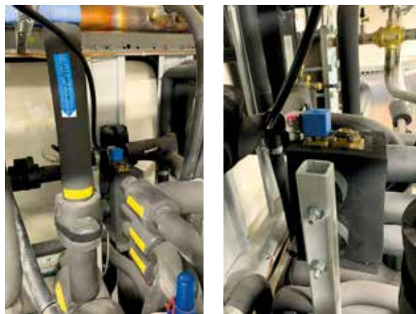
Eyector de líquido Danfoss.
